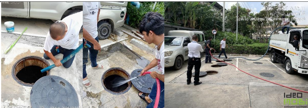
ภาพที่ 56 การตูดบ่อเกรอะ (วันที่ 13 ธันวาคม 2566)
