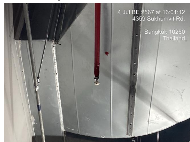
ภาพที่ 26 ระบบหัวกระจายน้ำดับเพลิงอัตโนมัติ
